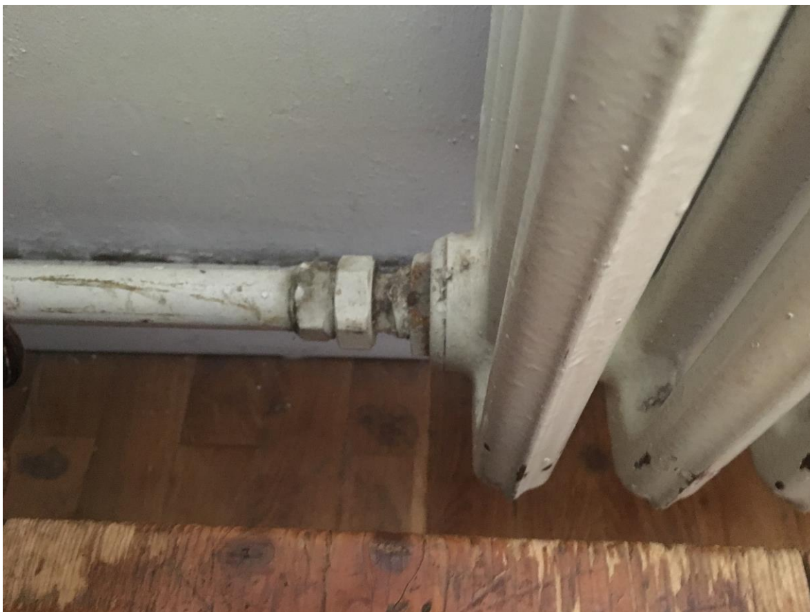
Foto č. 4 – pohled na stávající topné těleso – sv. šroubení
