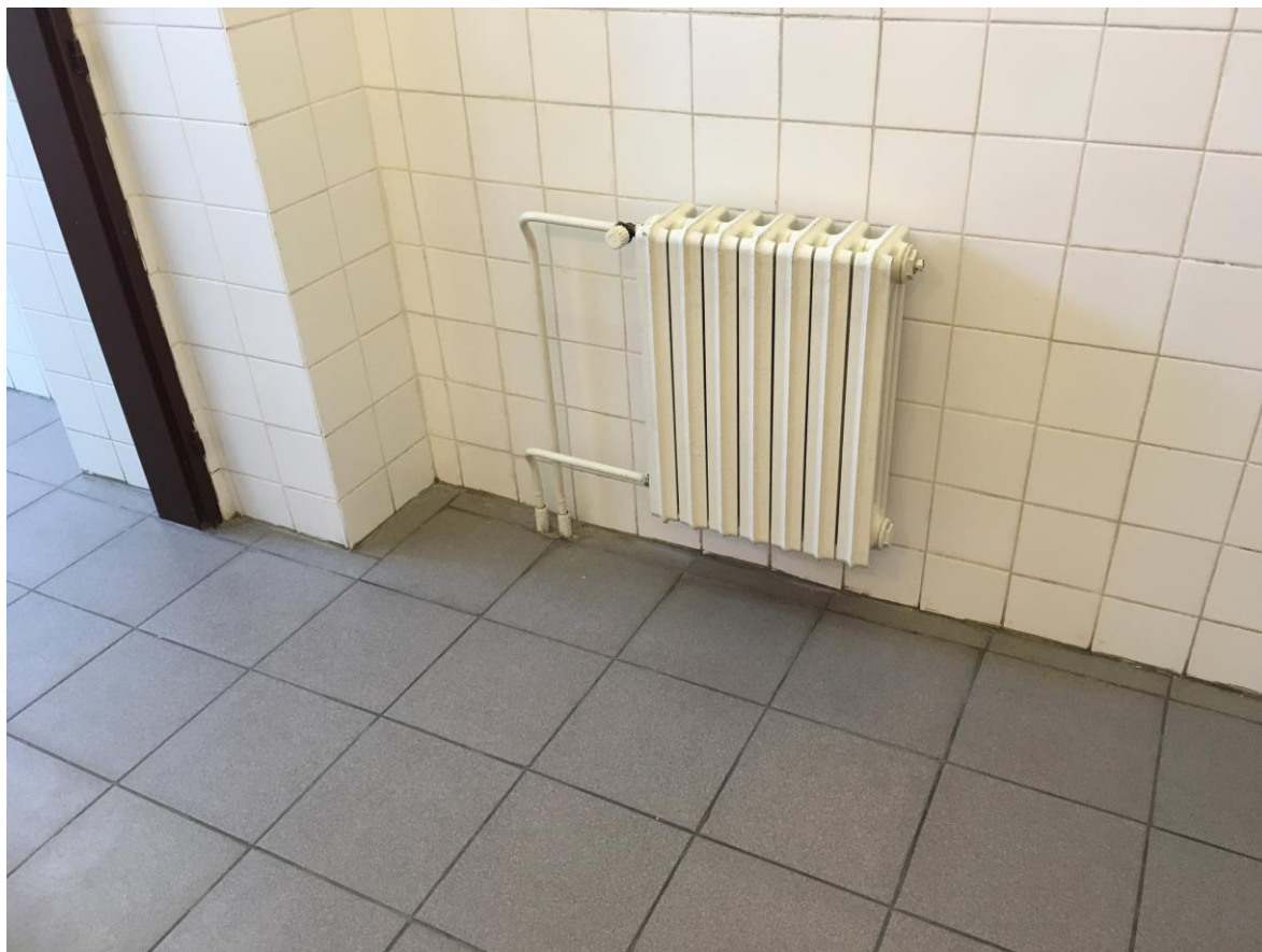
Foto č. 1 – pohled na stávající topné těleso Kalor 3
